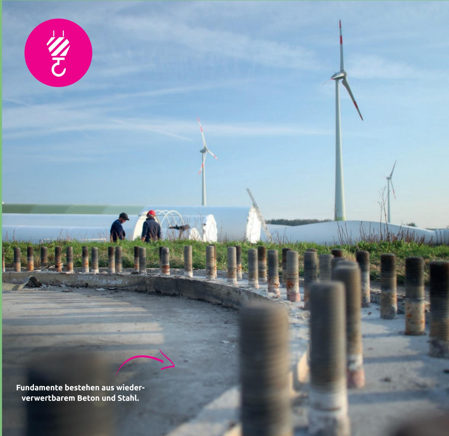
Fundamente bestehen aus wiederverwertbarem Beton und Stahl.
